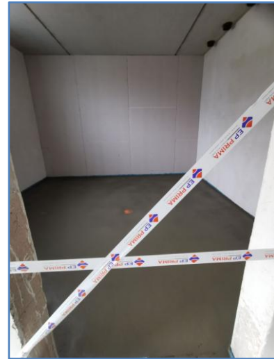
Der Estrich im Regieraum trocknet schon
